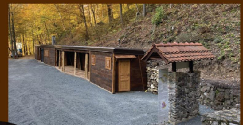
30-metarska armiranobetonska konstrukcija, zamaskirana drvom, svojim izgledom oponaša rudarski rov. Sastoji se od 12 modula dugačkih 2,5 metara i u sebi ima integrirane sadržaje kao što su prostor za vodiče, kovačnica, skladište za alat, prostor za podjelu hrane, sanitarni čvor, te otvorene module za radionice i izložbe. (gore) U rudniku možete naći i na mitskog patuljka Bergmana, odnosno njegov dvojezični hologram (lijevo)
