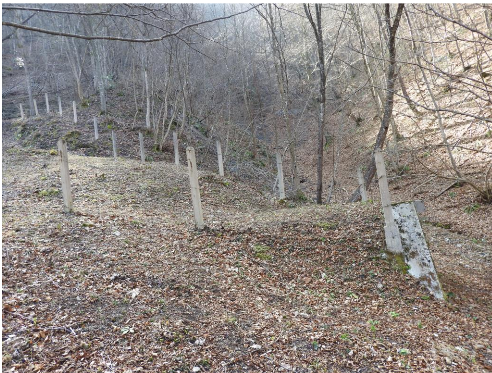
Fotografija 4-4: I. zona sanitarne zaštite (kaptaža L-5) – nedostatak žičane ograde
