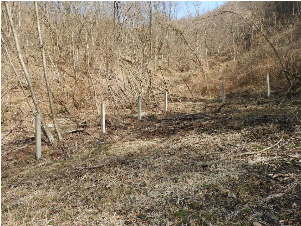
Fotografija 4-3: I. zona sanitarne zaštite (kaptaža L-6) – nedostatak žičane ograde
