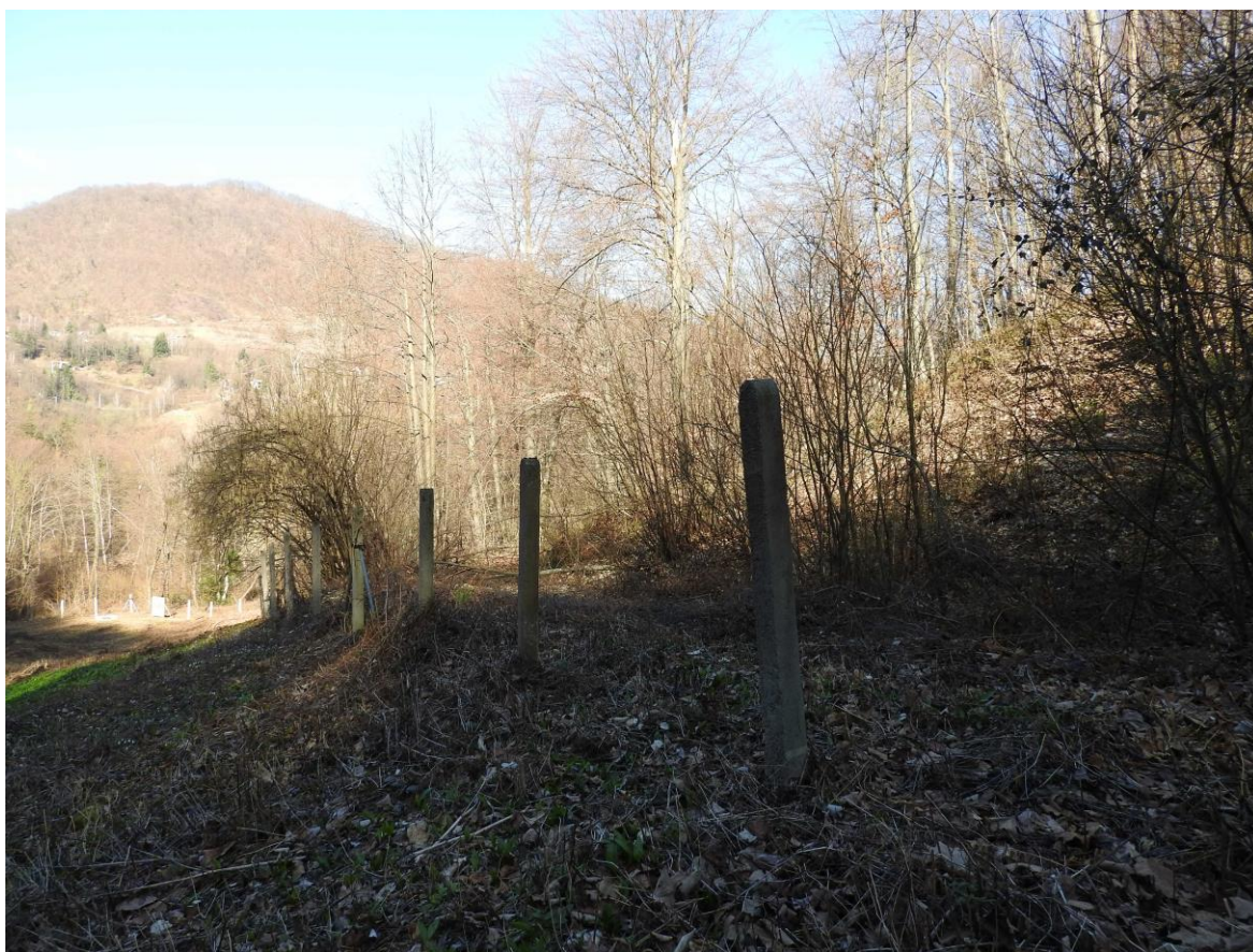
Fotografija 4-1: I. zona sanitarne zaštite (kaptaža L-2)– nedostatak žičane ograde
