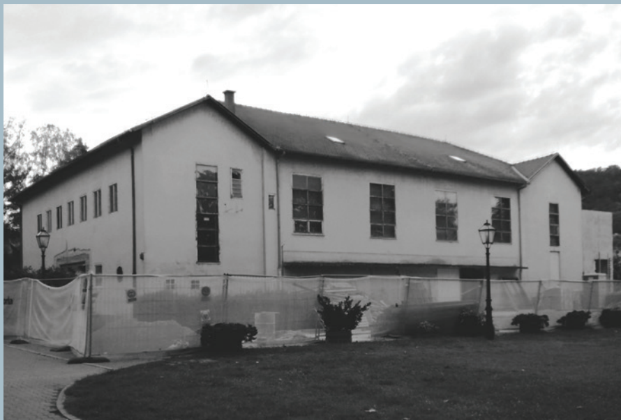
Zgrada Kina u rekonstrukciji
